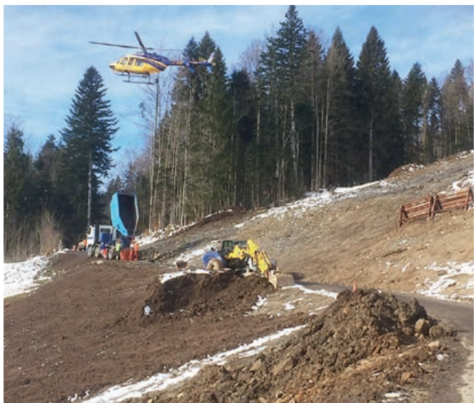
Der Sickerkies musste mit einem Helikopter hinauf transportiert werden.
