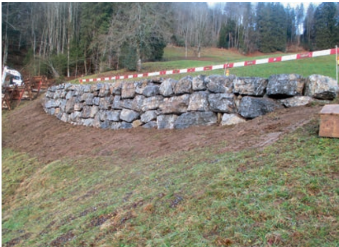
Blocksteinmauer 1 hinter der Skihütte Brend
