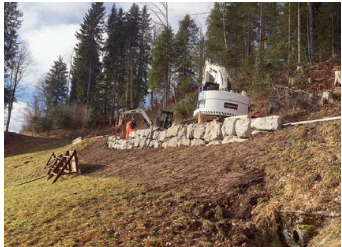
Blocksteinmauer 2 oberhalb Heimwesen Brunegg
