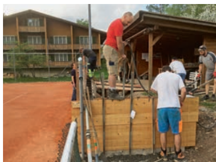
TCG-Präsident Armin Riebli (Mitte) betoniert die Mauern gleich selbst
