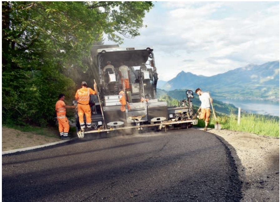
Ein 9 cm dicker Deckbelag wurde auf der ganzen Fläche eingebaut.
