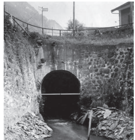
Bild 4: Alter Stollenauslauf Richtung Norden, wie er im Jahre 1767 erstellt wurde. Die Sohle des Stollenauslaufes wurde im Jahre 1850 bei der Entsepfung des Aarieds ca. 1 m tiefer gelegt um das Gefälle zu erhöhen. Im Jahre 1900 wurde hier Wasser ausgeleitet zum Betrieb einer Uhrensteinschleiferei sowie zur Stromerzeugung für das Hotel Krone. Der Bauschutt im Vordergrund sind die Überreste des Kanals. Dieser musste beim Ausbau des Lungernersee-Kraftwerkes im Jahre 1923 beseitigt werden. Kurz nach dieser Aufnahme wurde das Profil des Stollens wesentlich vergrössert.
