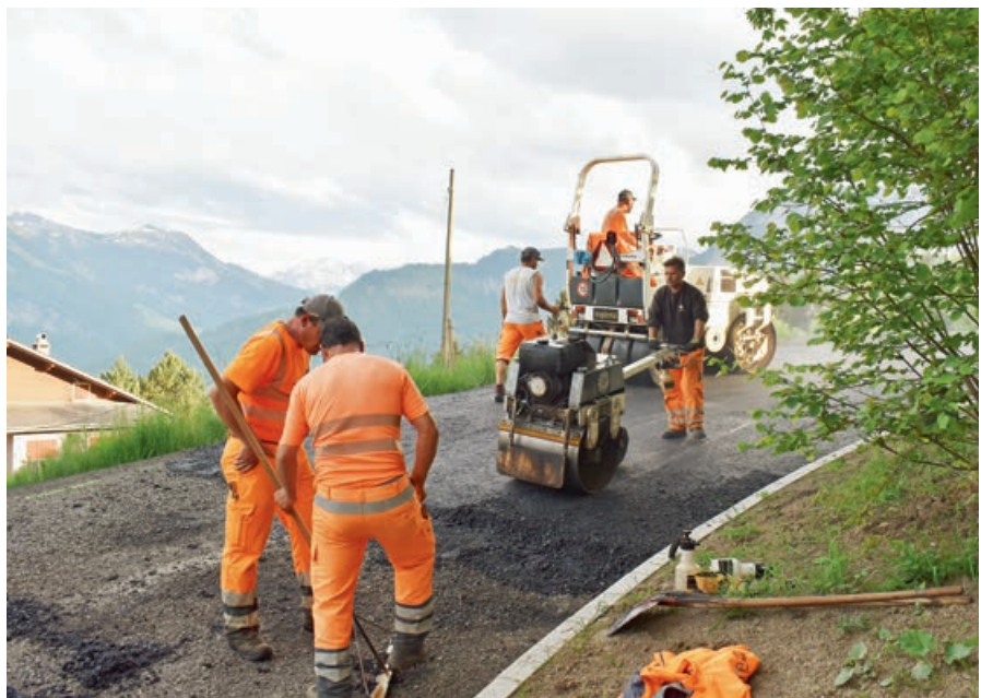
Die Belagsarbeiten sind abgeschlossen, die Bergstrasse präsentiert sich nun in einem guten Zustand.
