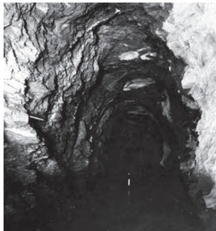
Bild 3: Das von den Tirolern ausgebrochene Tunnelgewölbe in der Wangformation unter der Talacheri 5 . Die Breite des Ausbruches betrug ca. 1.8 m und die Höhe ca. 3.6 m. Die Tiroler haben in 2 Jahren die ganze Strecke von ca. 100 m ausgebrochen, was ca. 650 m 3 oder 1800 t Gestein entspricht. Auffallend ist die relativ schwache Strömung des Wassers. Das Foto entstand vor der Aufweitung des Rudenzer Stollens im Jahre 1923.
