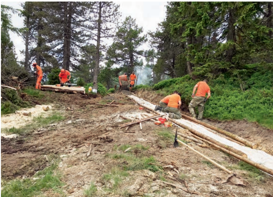
Der Zivilschutz Obwalden stand im Juni mit einer Arbeitsgruppe eine Woche lang in Giswil im Einsatz.
