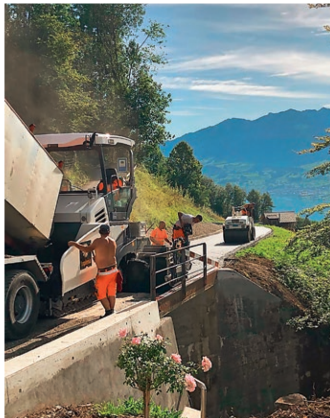
Auf dem Streckenteil Hoflitegg zum Hirtbielrank wurde ein einschichtiger Belag aufgetragen.
