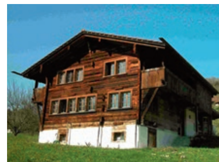
Das 1455 erbaute Haus im Studi konnte im letzten Moment nur dank beherztem Eingreifen vor dem Abriss gerettet werden.
