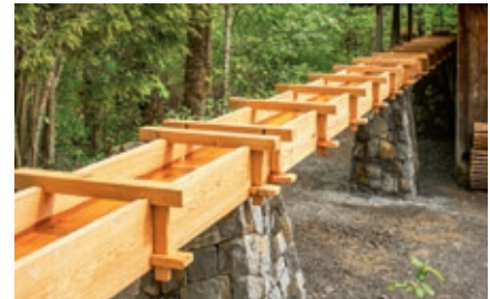
Der neue Holzkanal bei der Schlegelsäge im Kleinteil.
