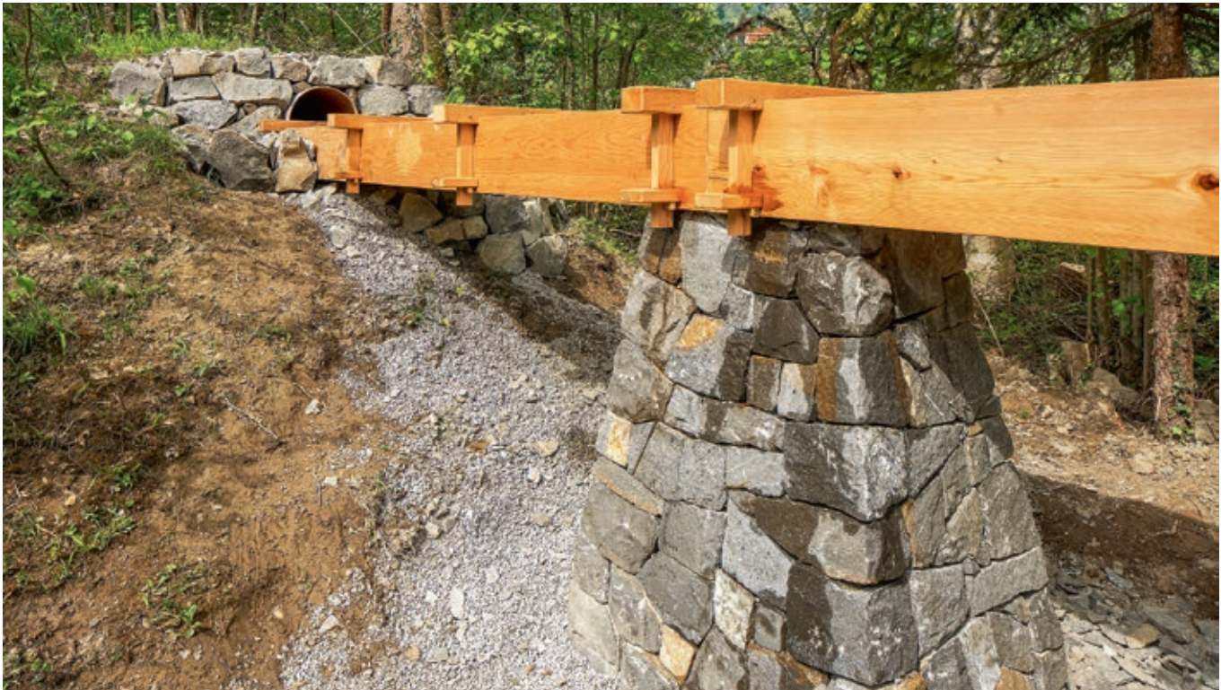
Die Lehrlinge der Markus Enz AG haben die neuen Trägerpfeiler erstellt.
