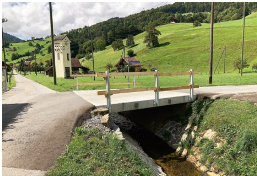
Die neue erhöhte Brückenplatte über den Rütibach.
