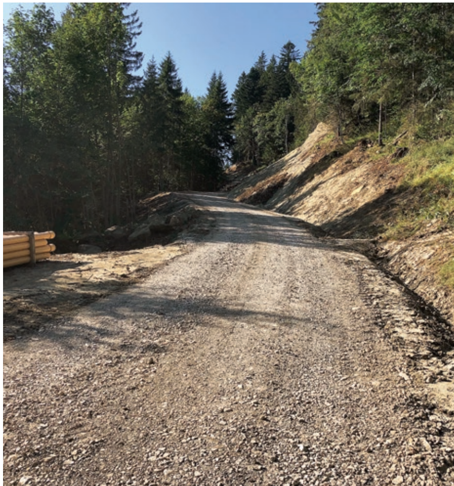
Im Verlaufe des Sommers 2020 erhält der sanierte Strassenteil einen OB-Belag.
