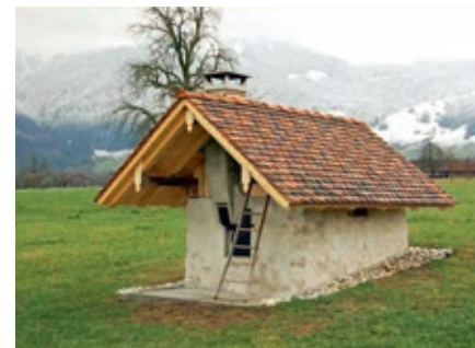
Das Dörrhaus in der Hirsern wurde mit wesentlicher Unterstützung der Stiftung Pro Giswil renoviert und kann auch als Pizzeria- und Brotbackofen verwendet werden.
