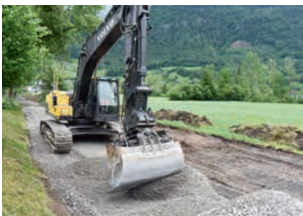
Peter Berchold, der erfahrene Baggerführer, verteilt das Koffermaterial.
