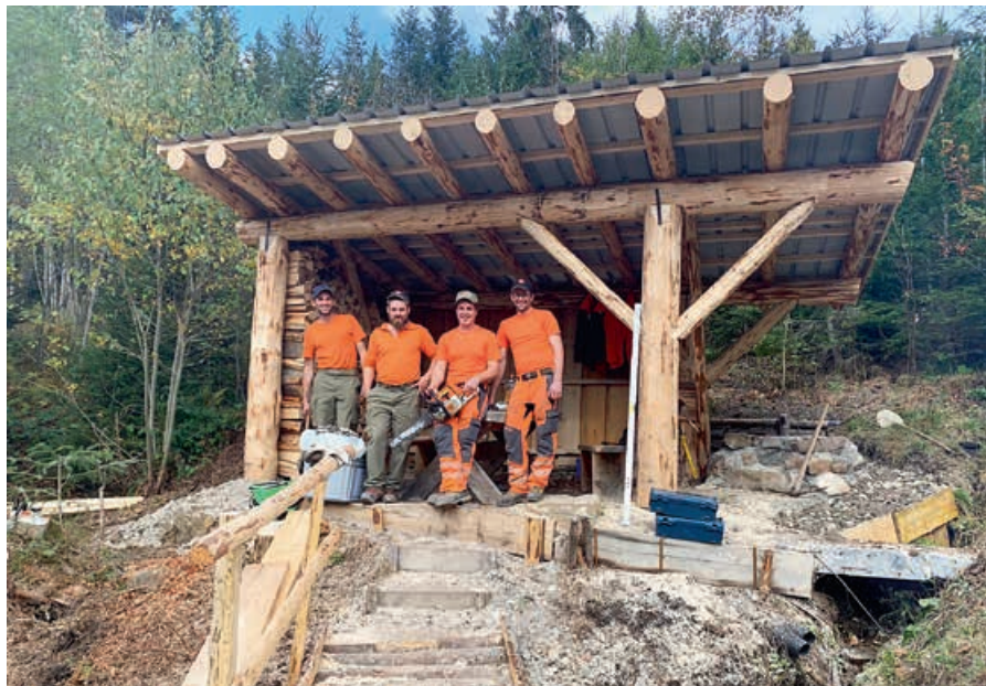
Der Unterstand im Zwirchiwald erstrahlt im neuen Glanz und lädt zum Verweilen ein.
