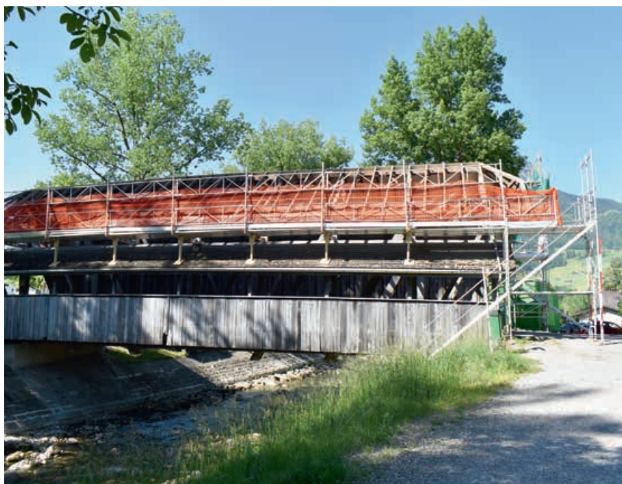
Das Dach der gedeckten Holzbrücke über die Giswiler Laui musste saniert werden.
