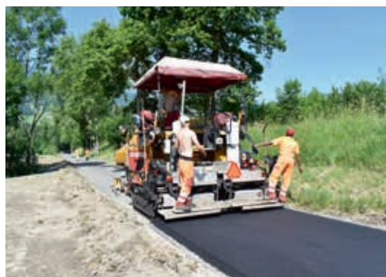
Die Firma SPAG konnte bei sehr gutem Wetter den Deckbelag einbringen.
