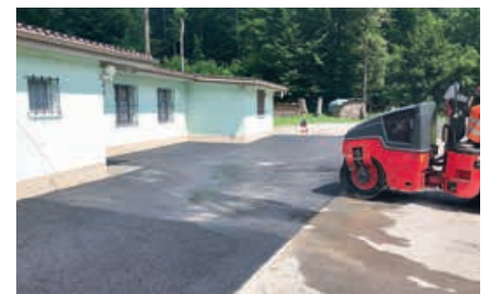
Gleichzeitig mit dem Bau der Rollskibahn wurde auch der Vorplatz der Schiessanlage der Sportschützen von Giswil mit einem Deck-Belag versehen.
