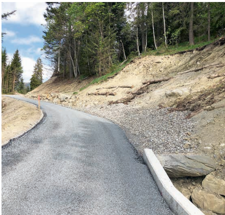
Die sanierte Strasse im Zwirchiwald kann wieder problemlos befahren werden.
