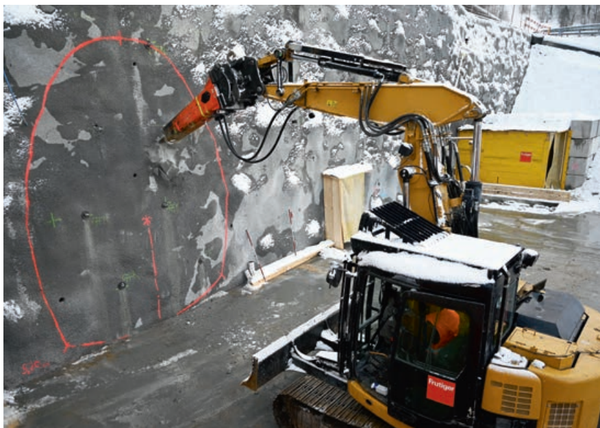
Mit dem Anspitzen des Erkundungsstollen beim Nordportal hat eine weitere Periode in der Umfahrung Kaiserstuhl begonnen.
