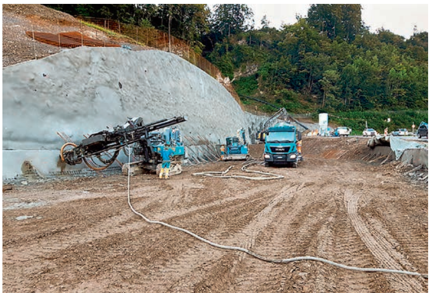
Litzenanker für die Dauer der zehnjährigen Bauzeit.
