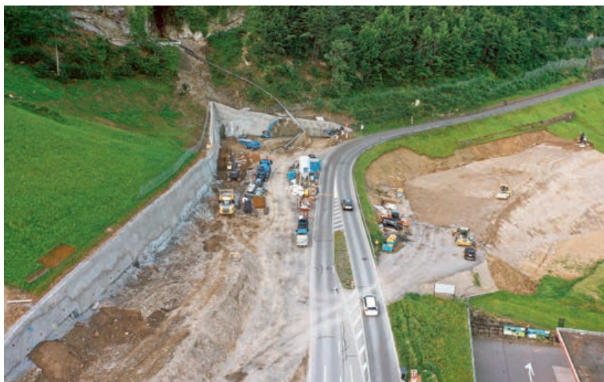
Blick auf die Baustelle beim OWi-Land, wo einige Veränderungen sichtbar sind.
