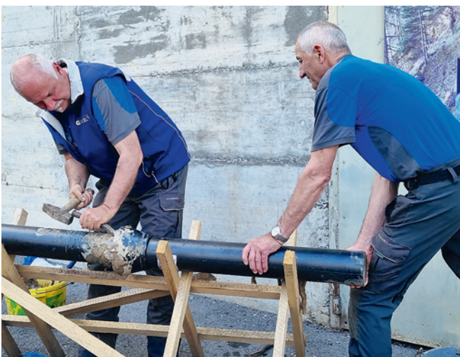
Armin Brechtold und Gregor Furrer zeigen eine alte Verbindungstechnik mit Blei.
