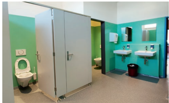
Komplett neue WC-Anlage
