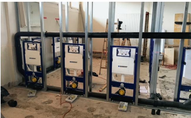
Nach dem Ausbruch Montage neuer Apparaturen
