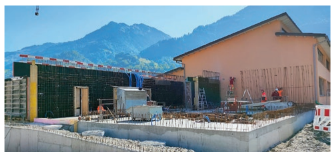
Der Anbau steht bereits im Bereich EG
