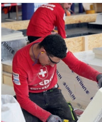
Simon (vorne) und Dominik konzentriert an der Isolationsarbeit
