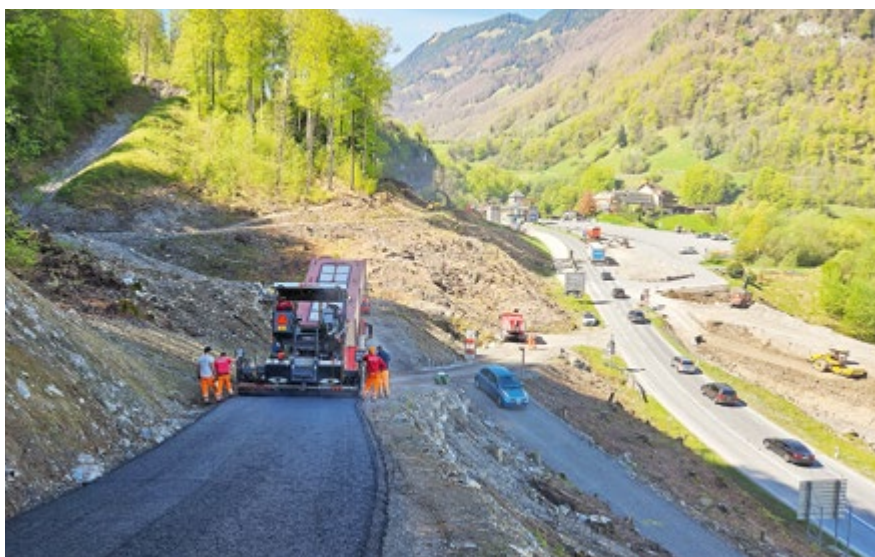
Baustellenerschliessung Bärfallenstrasse, Mai 2023
