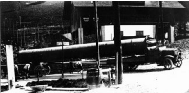
Transport von Druckleitungsrohren nach Unteraa
