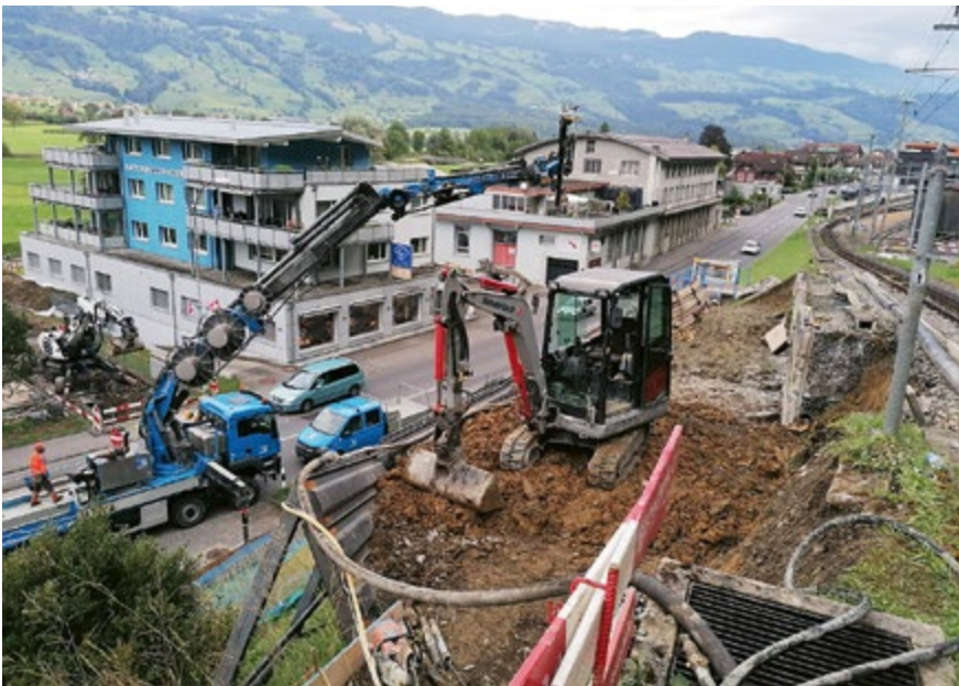
Leitung Entwässerung in Giswiler Aa, September 2023
