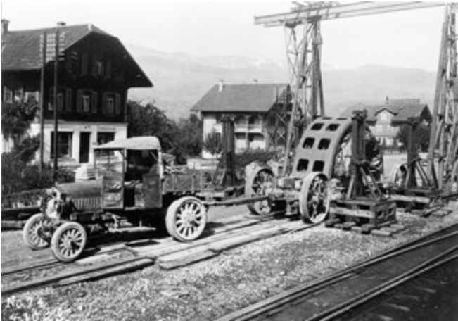
Umlad von Generatorenteilen bei der Bahnstation Giswil auf Strassentransport-Fahrzeuge
