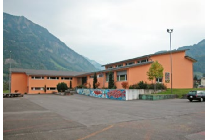
Schulhaus 1968 erweitert, wärmetechnisch saniert, Dach neu mit Vordächern, renoviert und neuer Fassaden-Farbtone
