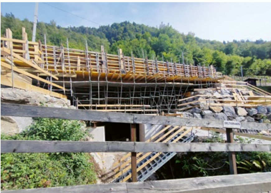
Bewehrung Deltigraben, September 2023
