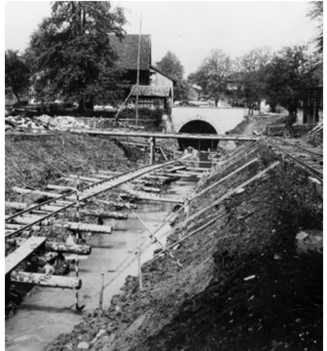
Verbreiterung des Aatunnels hinter der Krone sowie Verbreiterung und Abtiefung des Aagrabens
