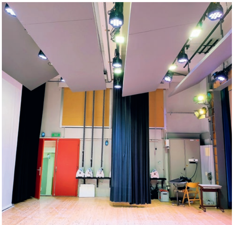
Bühne Kulturhalle nach der Sanierung
