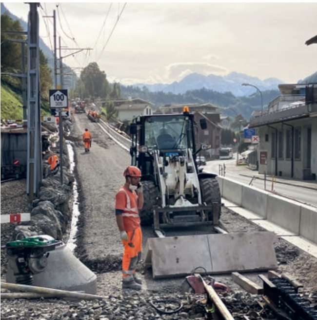
Bei der Zahnradstrecke vom Bahnhof Giswil bis zum Weidlibach wurden Schotterbett und Gleisanlagen komplett erneuert.
