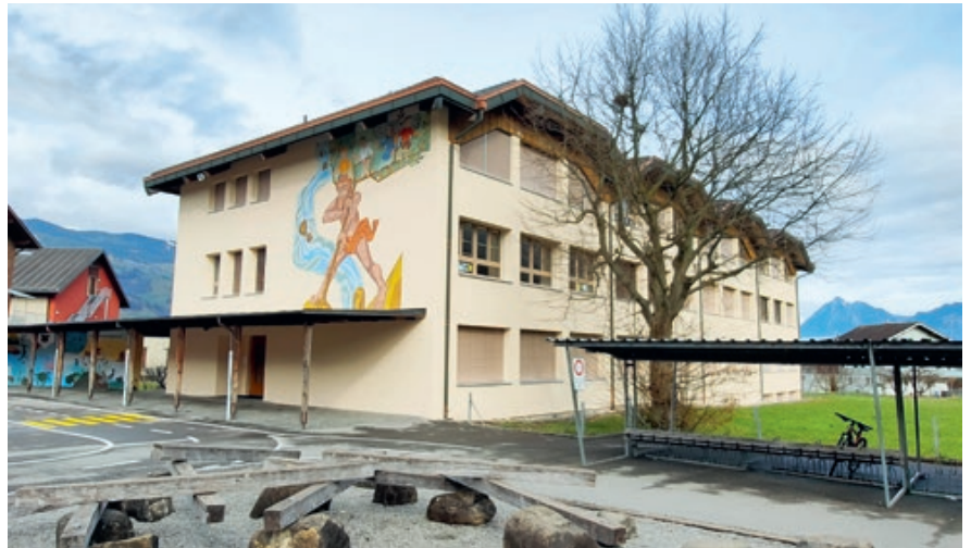
Schulhaus 1957 nach der Gebäudehüllensanierung
