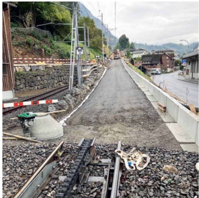
Bei der Zahnradstrecke vom Bahnhof Giswil bis zum Weidlibach wurden Schotterbett und Gleisanlagen komplett erneuert.
