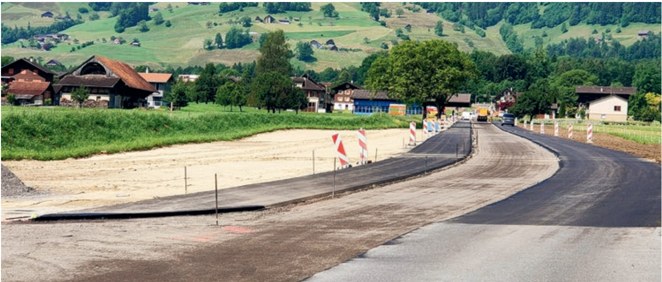
Schwerzbachstrasse Einbau Tragschicht
